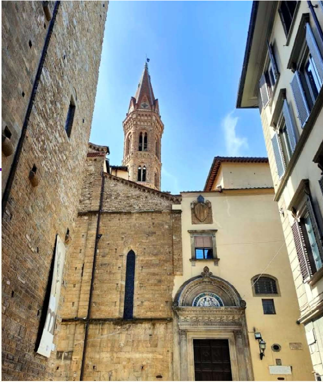
Uno scorcio della facciata della Badia con il campanile, da Google maps, foto di Andrea Manessi, maggio 2024.
